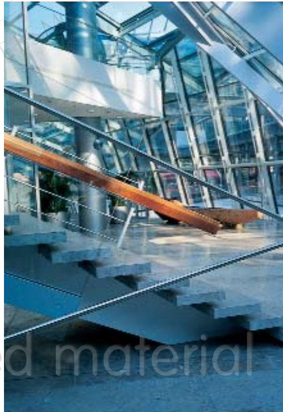
Günter Behnisch, Stefan Behnisch, Behnisch, Behnisch und Partner. Norddeutsche Landesbank. Hannover, 1996, 1997–2002. Außenansicht. Foyerbereich.
